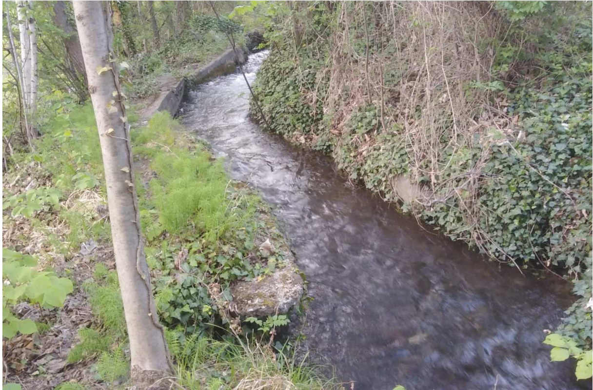
Fig. 6 – Lo stesso canale fotografato più a valle, dopo che ha ricevuto l'acqua scaricata dal canale della Pianura. Anche qui il progetto autorizzato prevede la posa della tubazione in acciaio ma il canale verrà mantenuto
