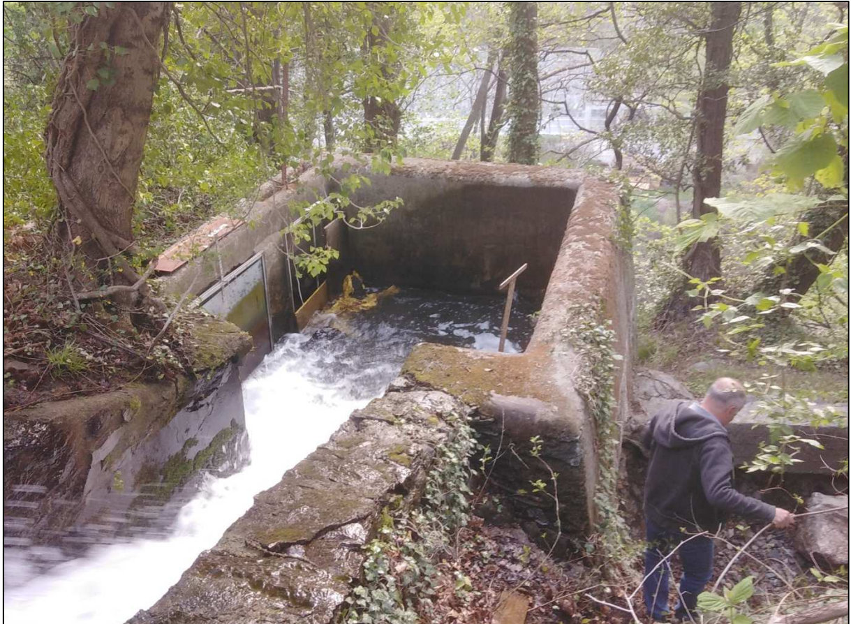
Fig. 3 – Vista da monte del manufatto di raccordo tra l'impluvio naturale ed il canale del Borgo
